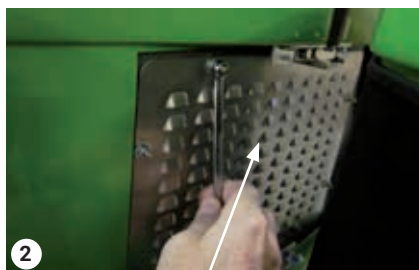
Płytkę stalową i gumową uszczelkę
